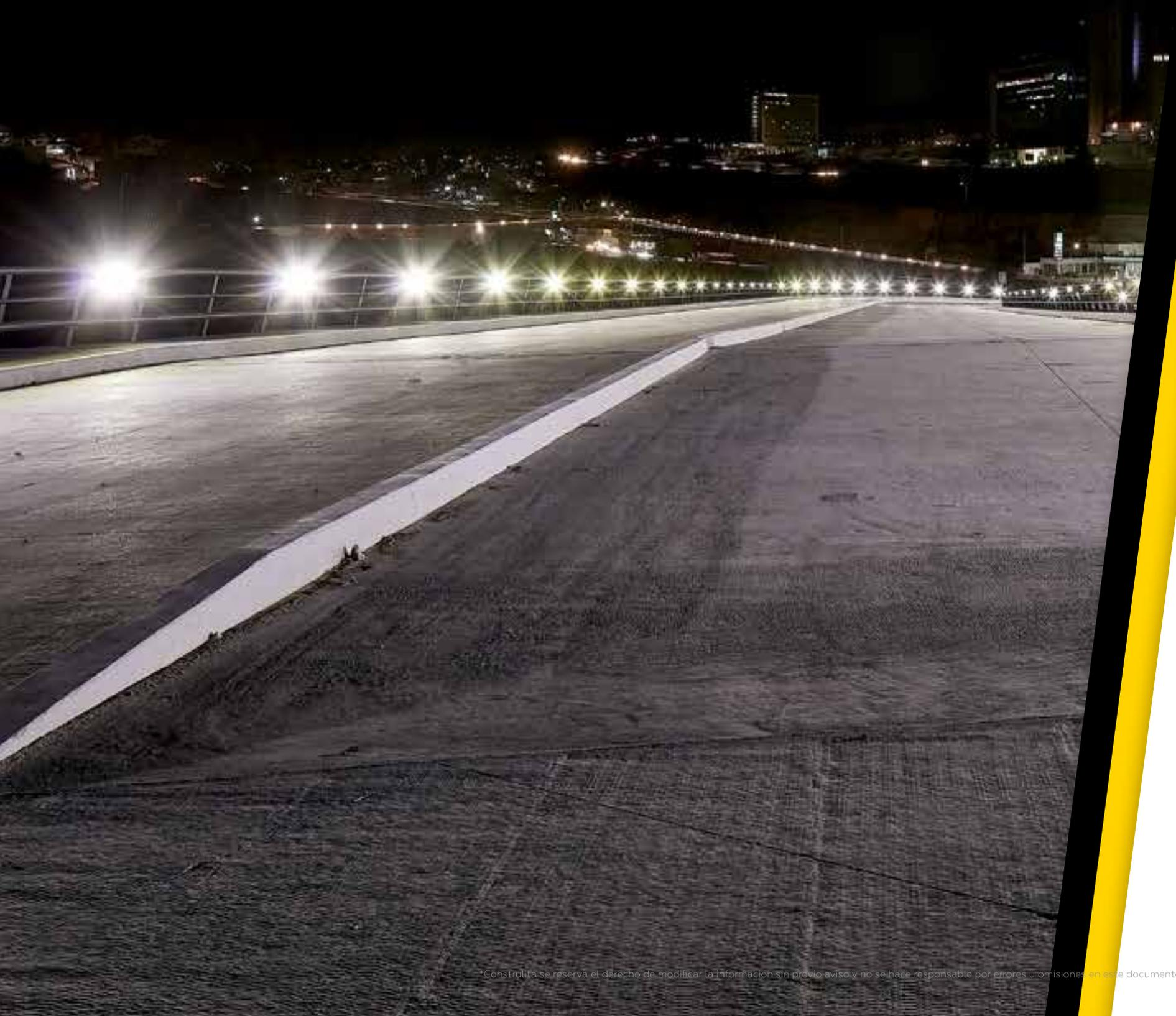
Luminario lineal diseñado para instalarse a baja altura en el parapeto de las vialidades.
